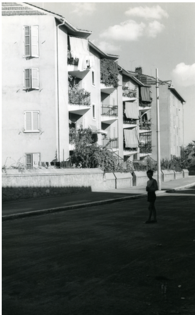
Fig. 3. Autore ignoto, Roma, Quartiere INA–Casa Tiburtino, 1950–1956. Lotto E, case in linea. Per gentile concessione dell’Accademia Nazionale di San Luca, Roma. Archivio del Contemporaneo. Fondo Ridolfi-Frankl-Malagricci.
