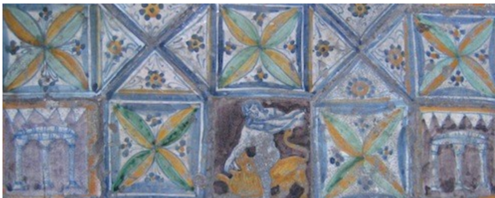
Fig. 15 Pavimento col «pontano», cappella Pontano, Napoli, c. 1492
