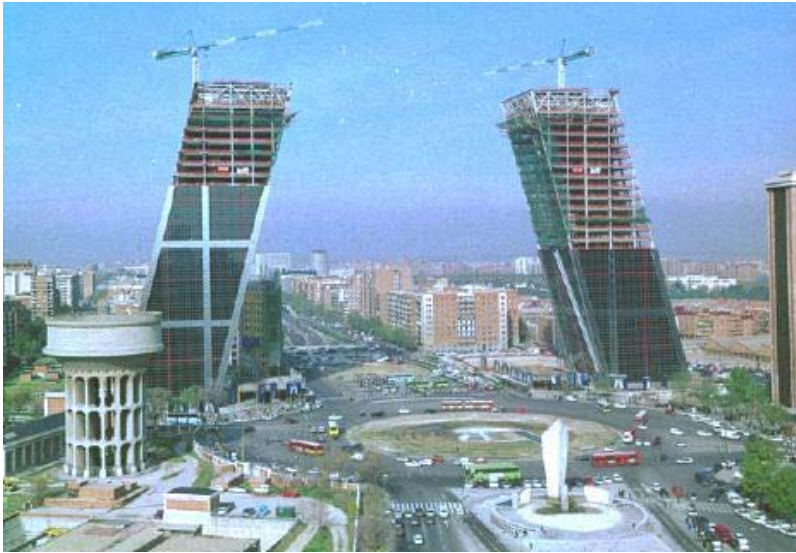
Fig. 1. The Torres KIO and the Plaza Castilla.
