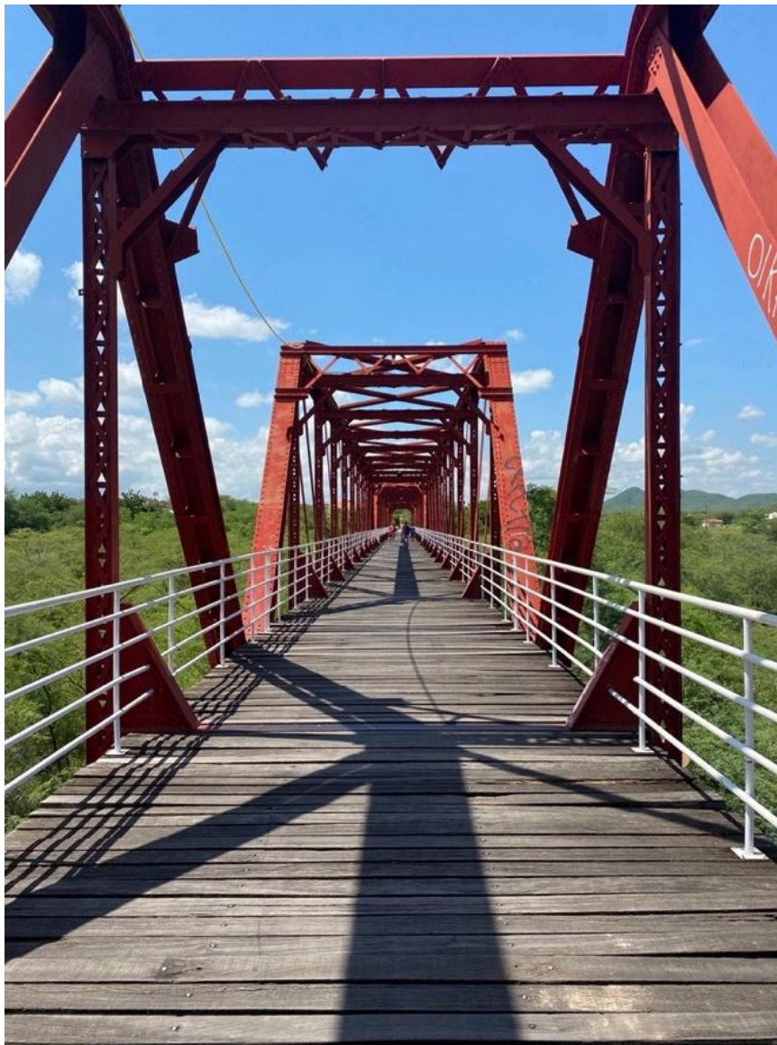
Figura 1: Ponte Metálica de Quixeramobim–Quixeramobim | Ribamar Oliveira, 2022
