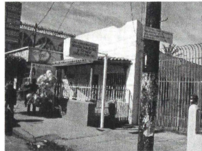
Foto 5. Antigua casa-habitación convertida en clínica
